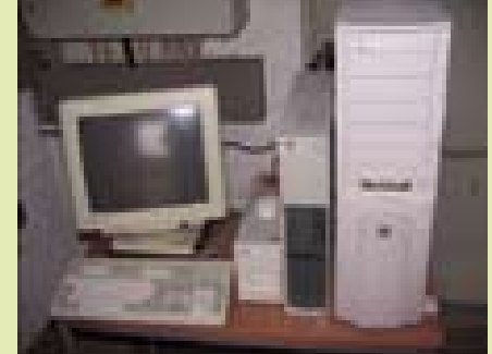
Der zur Datenaufnahme benutzte PC wurde bei uns in der Heizungsanlage installiert und wird nach Beendigung wieder aufgebaut
